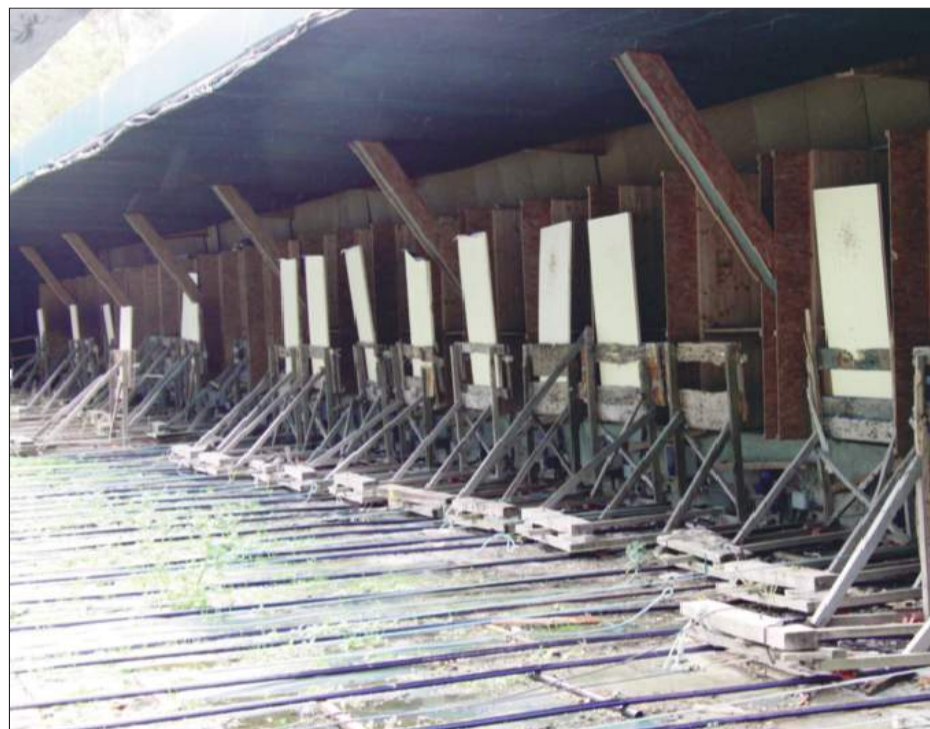
Vista desde el exterior de la galería de 100 m. de los carros automatizados para los blancos
